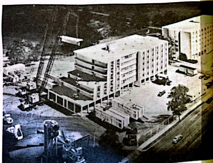
Opérations de montage.
