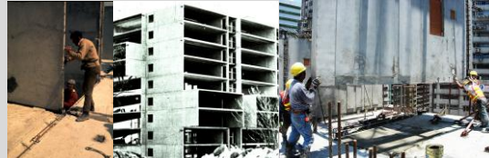
Panneaux de béton préfabriqué
